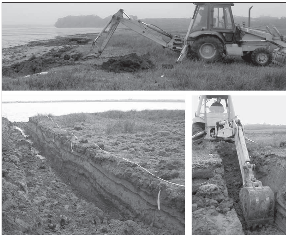
FIGURA N° 4 UTILIZACIÓN DE RETROEXCAVADORA PARA LA PERFORACIÓN DE FOSAS
