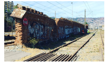
Figura 1. Vista general del muro Andes desde el interior de los terrenos de EFFE. Fuente: Urrutia M. (2019).
