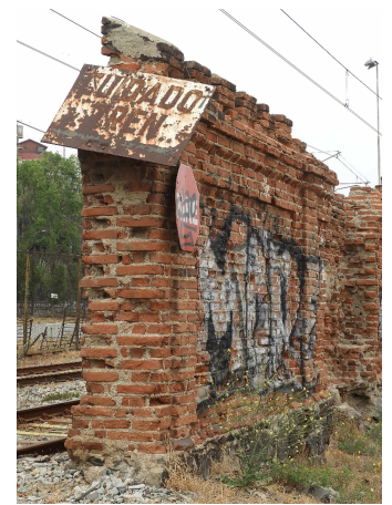
Figura 2. Vista lateral del muro, donde se puede apreciar la morfología y espesor de los paños. Se distinguen los detalles de pilastra y remate superior de almenas. Fuente: Urrutia, M. (2019).
