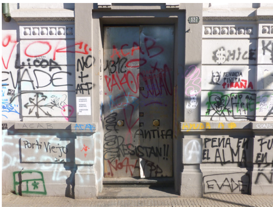
Imagen 1. Fotografía de muro, Av. Libertador Bernardo O'Higgins, Santiago de Chile
