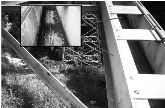
Figura 23. Localización de los dos sensores en el cordón inferior del puente
