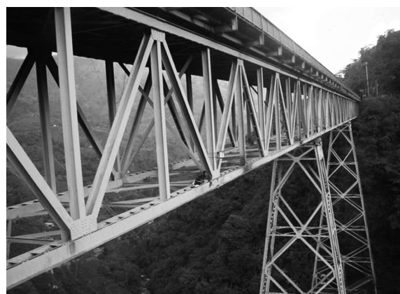
Figura 1. Armadura de paso inferior y dos torres de celosía en acero
