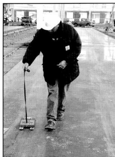
Figura 8. Centro de Distribución Fashion's Park. Personal de DICTUC S.A., ejecuta las mediciones de planeidad con equipo de medición F-Meter
