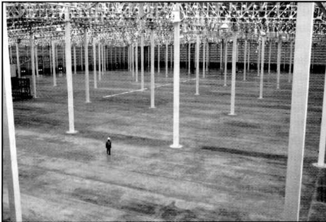
Figura 5. Centro de Distribución Nestlé. Pavimento construido entre diciembre de 2000 y enero de 2001. Propietario: La Casa de Piedra S.A. Quilicura, Santiago, Chile. Inspección Técnica: CIT-DICTUC S.A.
